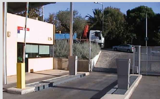
Imagen instalación con operador control acceso y salida
